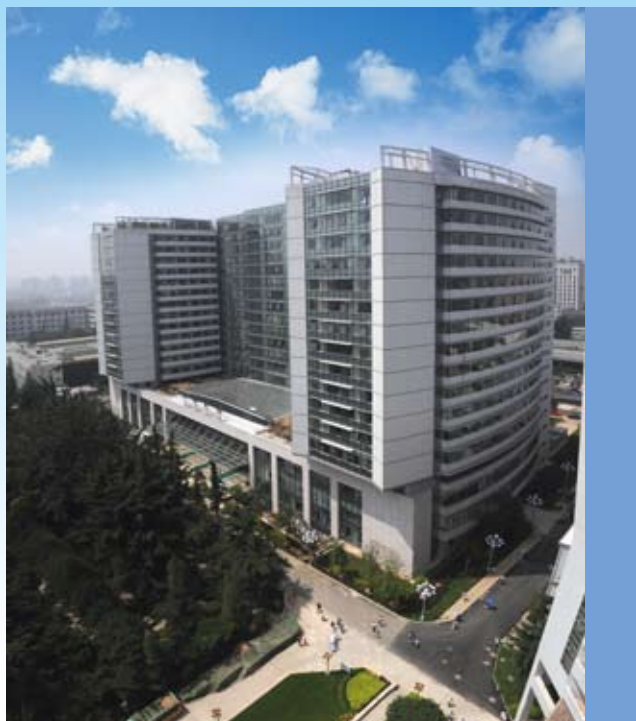
Surgical Center of the PLA General Hospital 中国人民解放军总医院外科大楼
